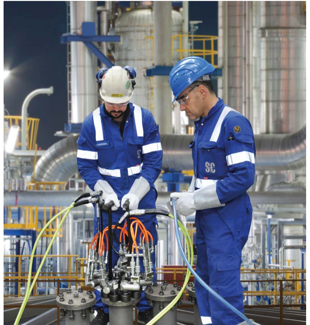
Ein Höchstmaß an Präzision und Verantwortung: Mitarbeiter von Schmidt + Clemens bei Einbauarbeiten an einem Steamcracker. Fotos: Schmidt + Clemens
