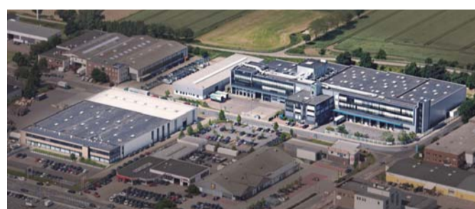
Blick auf den Hauptsitz in Stuhr / Bremen mit vier Verkaufsabteilungen und dem Zentrallager für Rohrverbindungen
