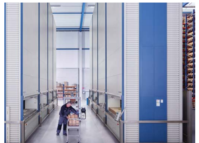
Kommissionierung von Armaturen mit Hänel Lean-Liften
