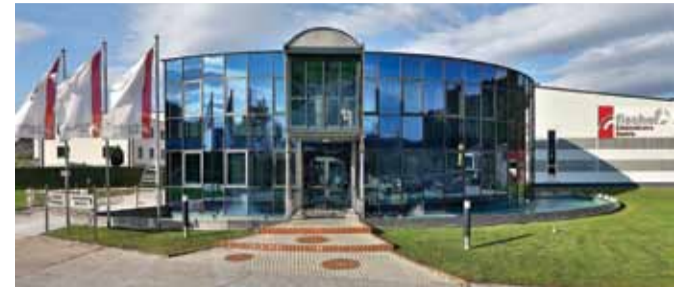
fischer Edelstahlrohre Austria in Griffen
