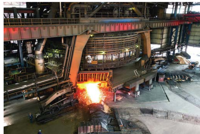
Bei ArcelorMittal in Kasachstan wurden die Hochöfen 2 und 3 mit neuer Anlagentechnik ausgestattet. Fotos (4): SMS group
