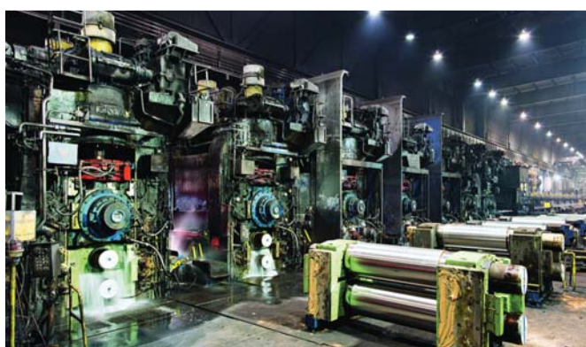
Bei ThyssenKrupp Steel Europe wurde die Warmbandstraße modernisiert.
