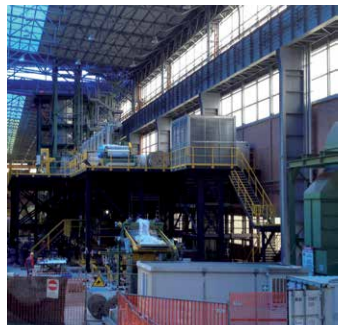
Die neue Glühe, die im dritten Quartal in Betrieb geht, im Bau
